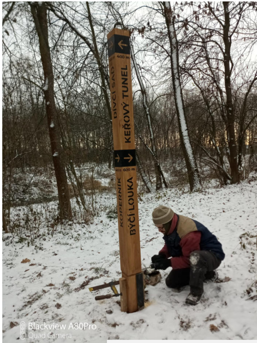
Instalace navigačních sloupků u řeky Moravy.
